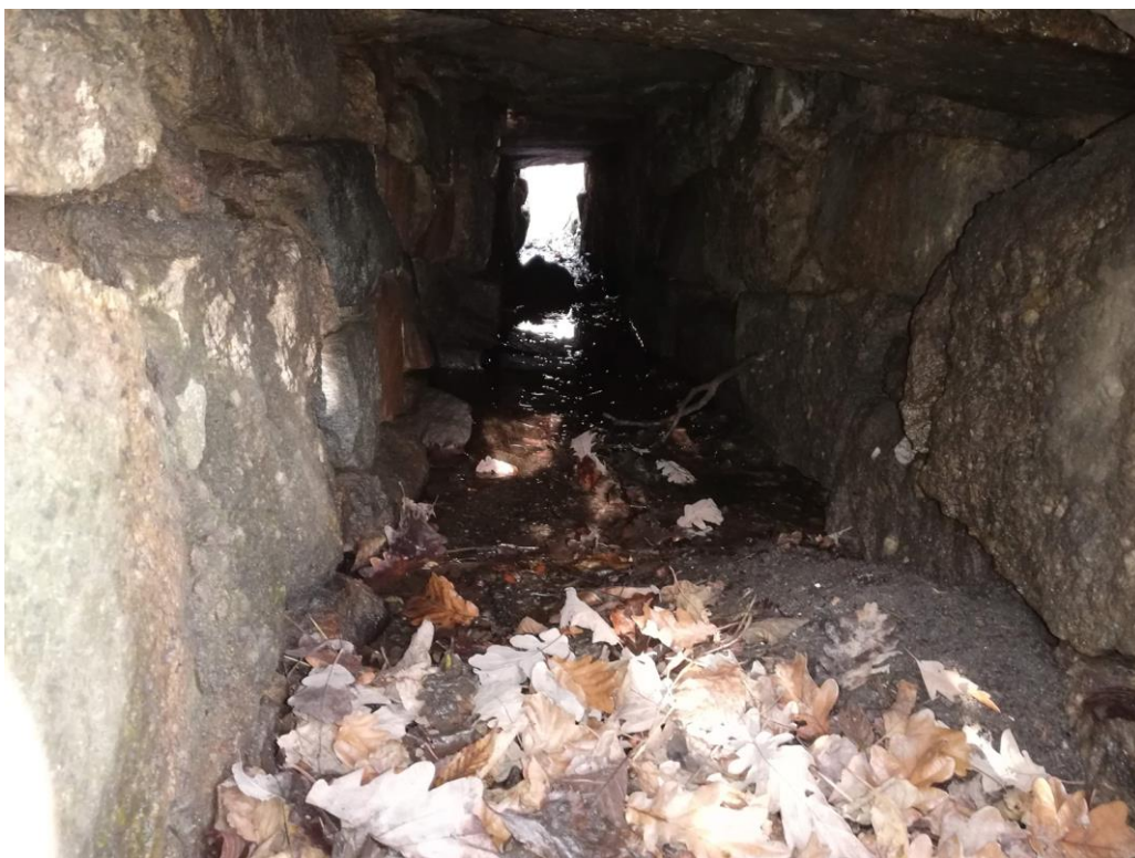
Obr. č.5 – Pohled od vtoku na opěry propustku
