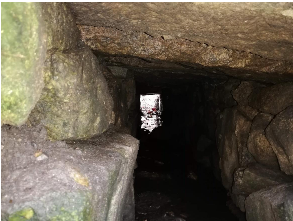
Obr. č.8 – Pohled od výtoku na opěry propustku
